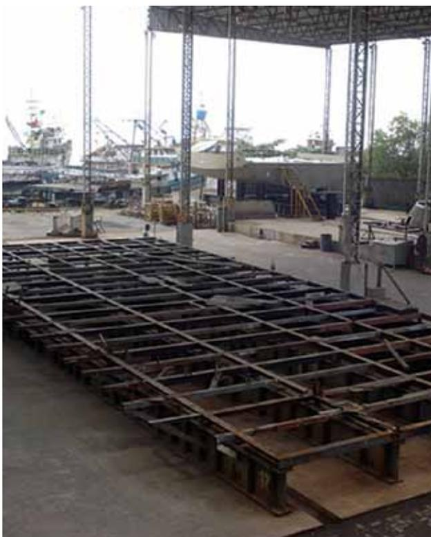
As obras dos dois rebocadores da Tug Brasil, contrato assinado em maio último, estão indo de vento em popa. Essa é uma nova geração de rebocadores com propulsão azimutal. Estamos empenhados nessa fase estrutural da obra para que possamos obter os dois cascos submontados em paralelo, visando a edificação conjunta – agregando, assim, produtividade à construção. O valor desse negócio gira em torno de R\$ 30 milhões, capaz de gerar cerca de 300 empregos diretos.
